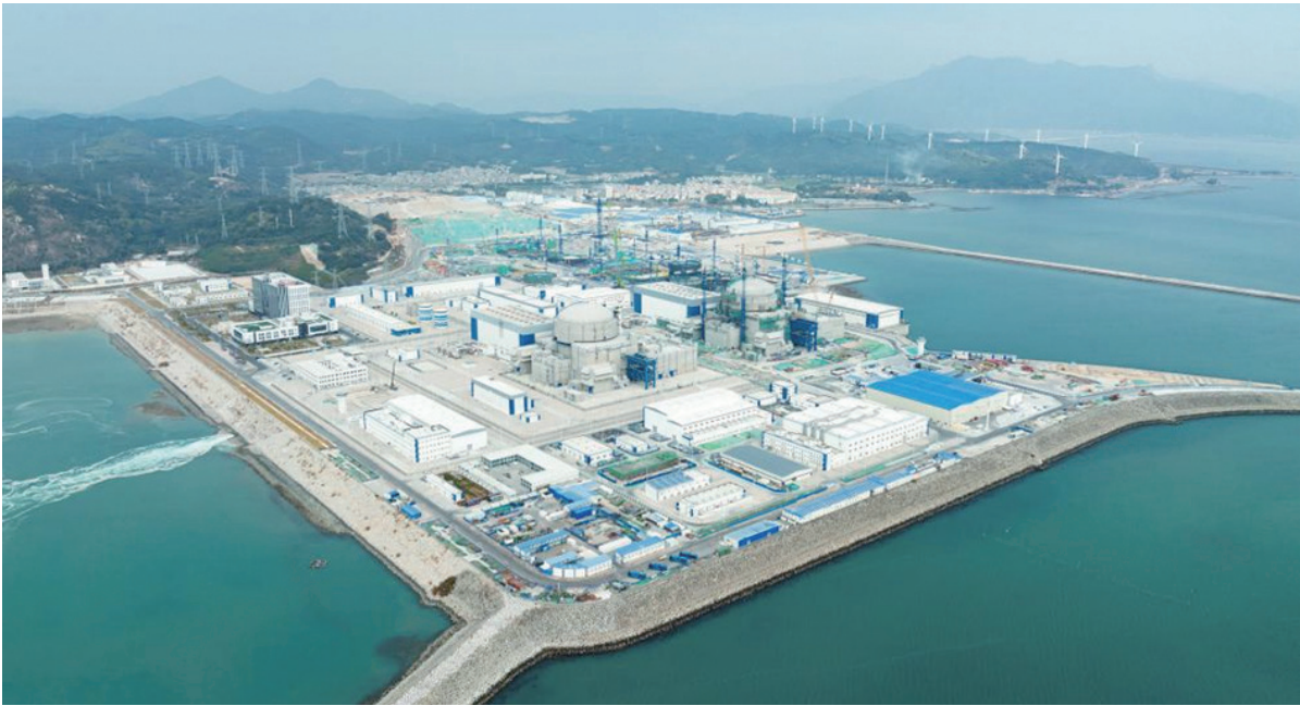
2025 年 1 月 1 日拍攝的建設中的漳州核電站（無人機照片）。新華社 發（漳州核電供圖）
